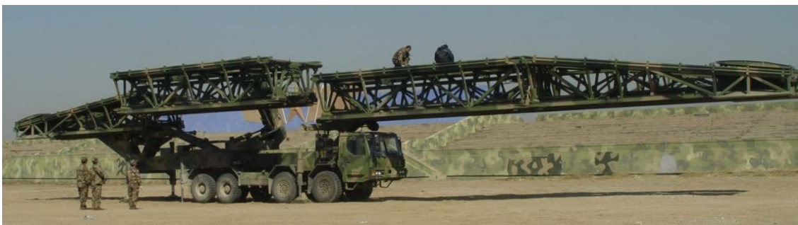
รูป 3-16 การยกช่วงสะพานที่สี่
