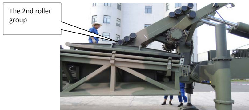
รูป 3-32 โครงวางถูกยกขึ้น
