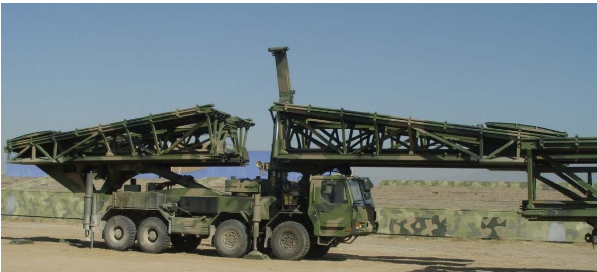
รูป 3-10 ปลายช่วงสะพานถูกดันออก
